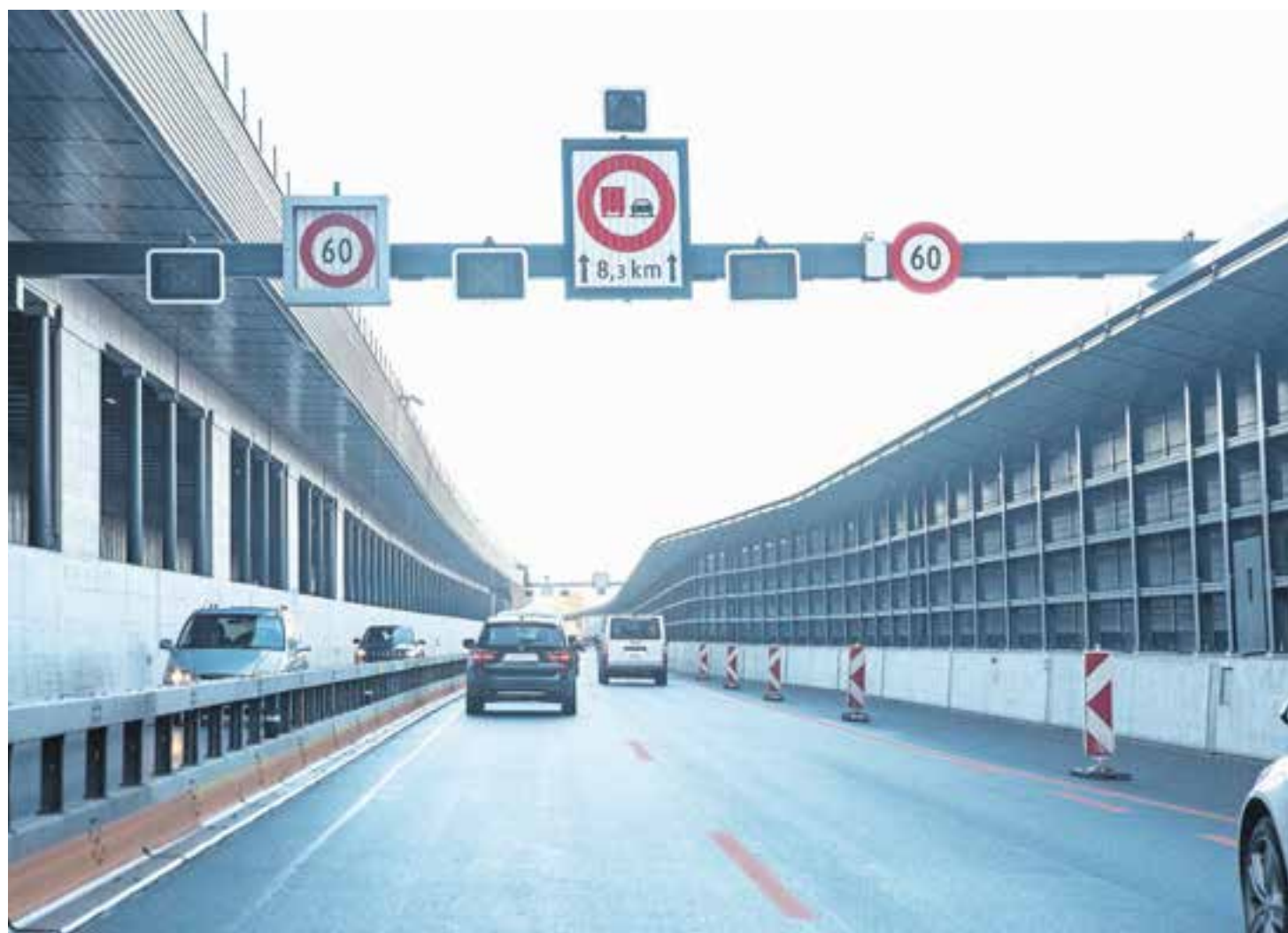
Der Baustellenbereich auf der Autobahn A2 bei Hergiswil.
